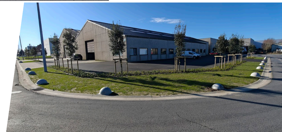
Houthulst: na het terreinbeheer
