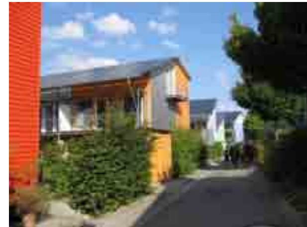
Aandacht voor energie in de Vaubanwijk te Freiburg (Duitsland): een goede oriëntering van de woning, het plaatsen van zonnepanelen en het integreren van een luifel tegen oververhitting in de zomer (wvi, 2008)
